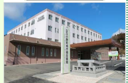
完成した公立小野町地方総合病院
