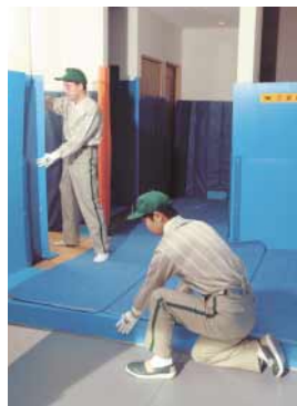
養生資材 玄関や階段、廊下などを保護する資材
