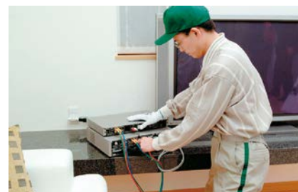
AV機器の配線取り付け
